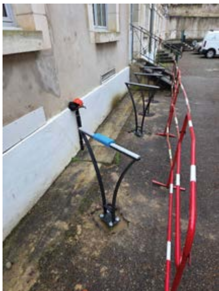
Mise en place de nouveaux supports pour vélo à la mairie
