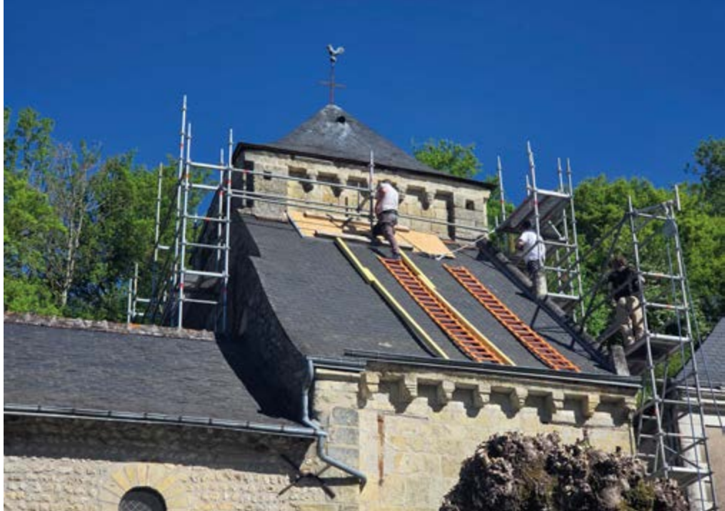
Début des travaux de restauration de la chapelle Saint-Georges
