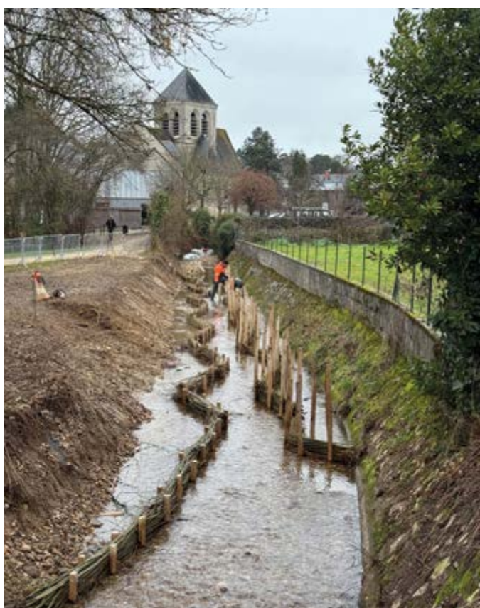
Continuité des travaux de renaturation de la Bédouire
