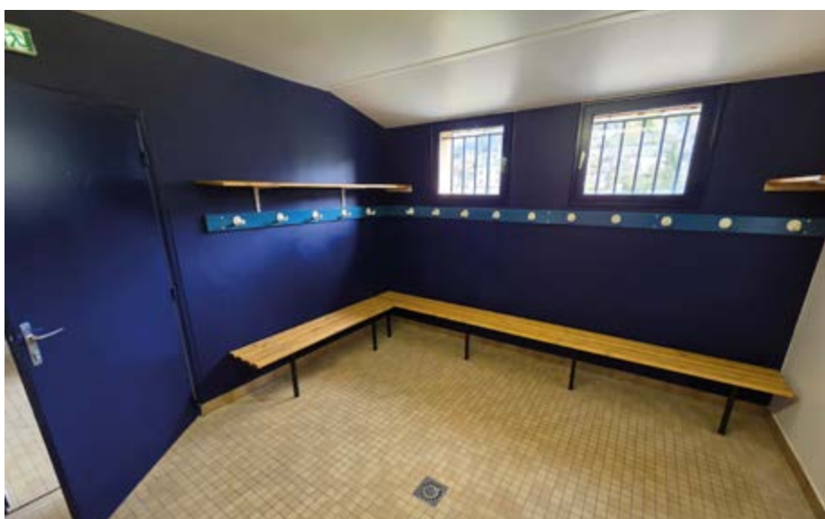
Peinture du deuxième vestiaire foot côté visiteurs
